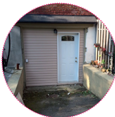
Avant travaux - entrée en conte-pente
