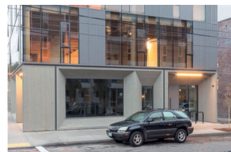
2 Ex. surélévation de mur-rideau
