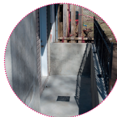
Après travaux - aménagement muret et escaliers d'accès
