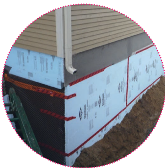
Exemple d'isolation extérieure de murs de fondation.
