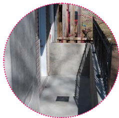
Après travaux aménagement muret et escaliers d'accès
