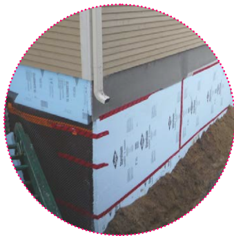
Exemple d'isolation extérieure de murs de fondation.
