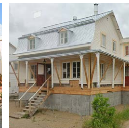
Pendant les travaux de rehaussement
