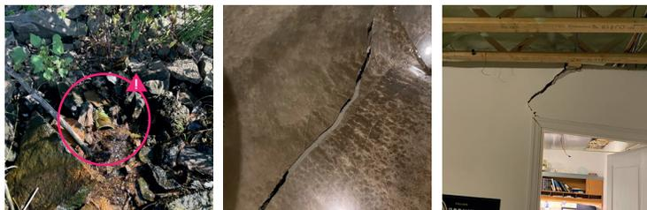
Exemple d'obstruction de la sortie du drain gravitaire dû à un mauvais entretien, provoquant des dommages structurels importants (soulèvement et bris de la dalle, fissurations, etc.) et une inondation.
