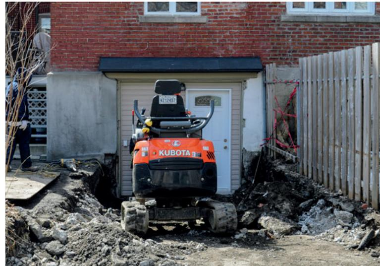
*Retrait complet de l'asphalte et des murets de soutènement.*
