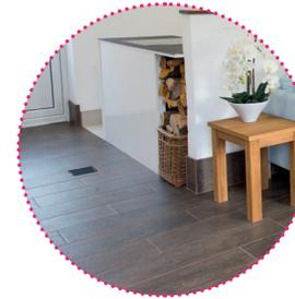
Exemple de finition de plancher imperméable en composite avec drain de plancher.
