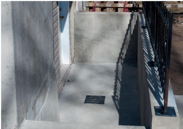
*Installation d'un nouveau système de drainage et de nouveaux murets et marches.*
