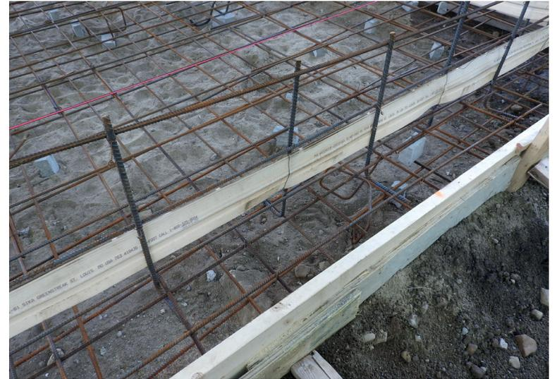
Plancher en béton armé (radier)
